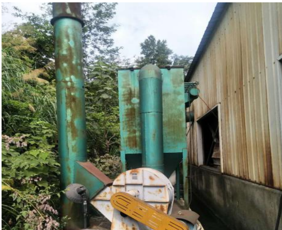
图 3 熔化废气处理设施
