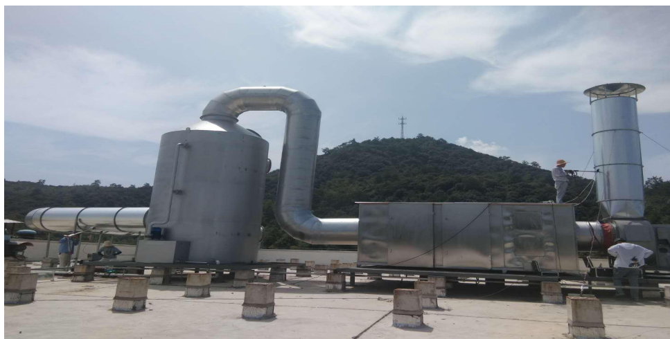
图 3 开炼、密炼废气处理设施
