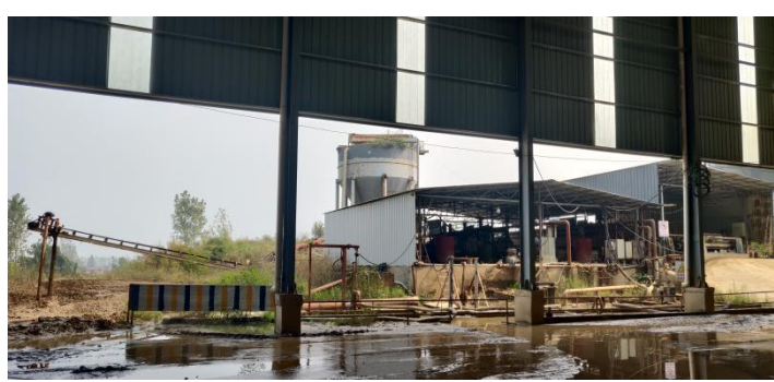
图6 沉淀水塔及压滤机
