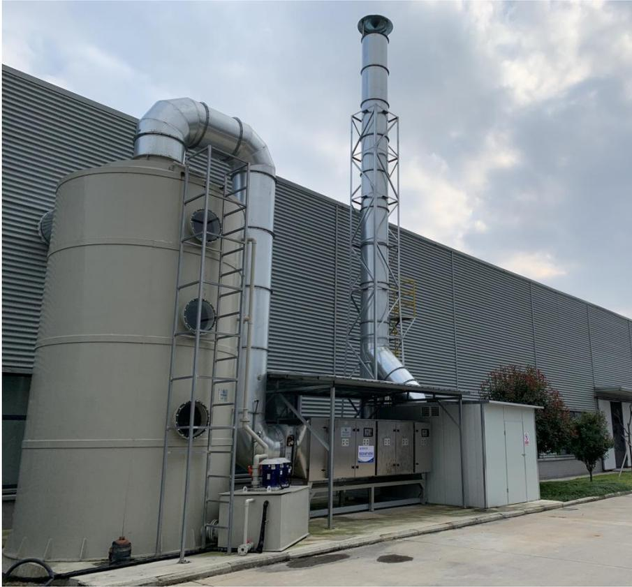
配料、二段混炼、开炼废气处理设备
