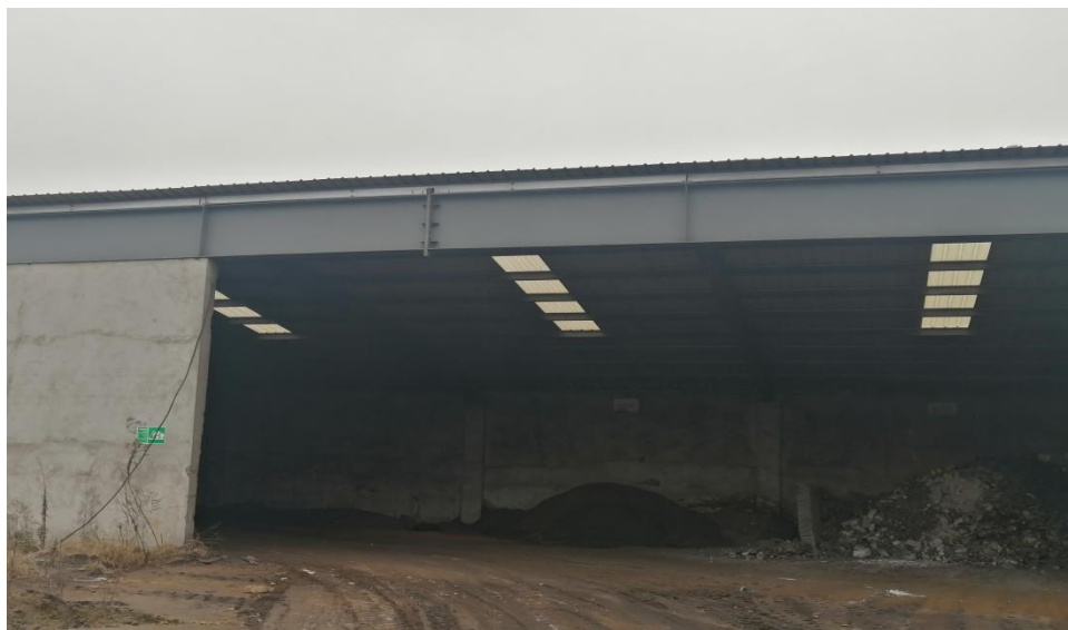
图5 固废暂存场所
