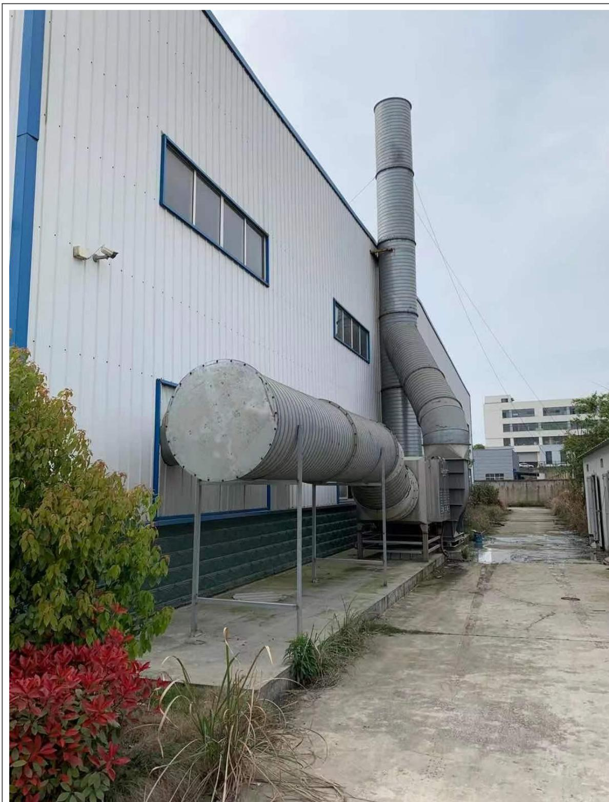
图 6-2 喷漆废气排气筒
