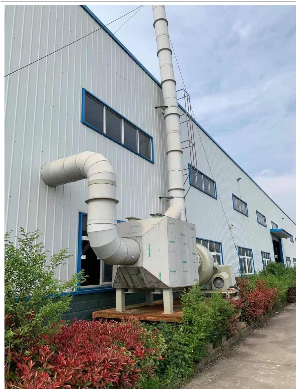
图 6-1 PP 焊接废气排气筒
