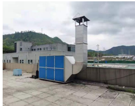
图 3-3 油烟废气处理设施排口
