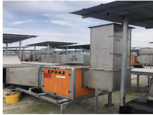
图 3-3 油烟废气处理设施排口
