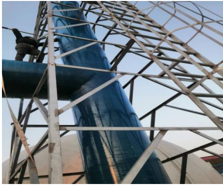
图 3-2 污水处理站臭气处理设施排口
