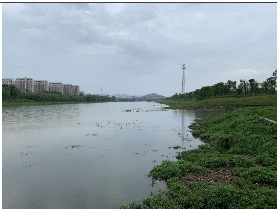
金桥大桥 右岸
