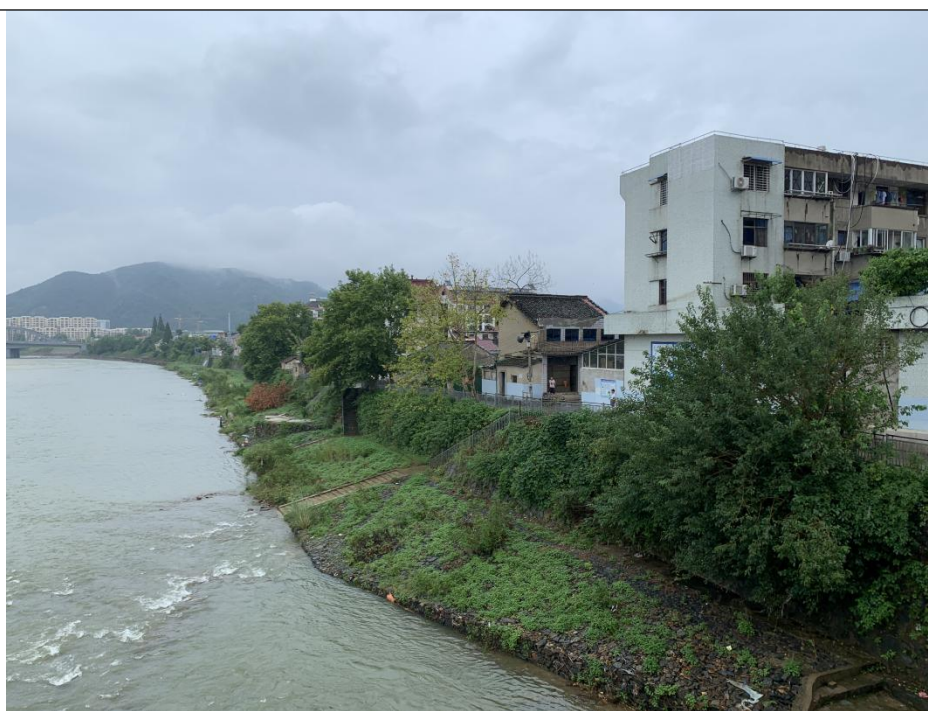
河沥溪大 桥左岸
