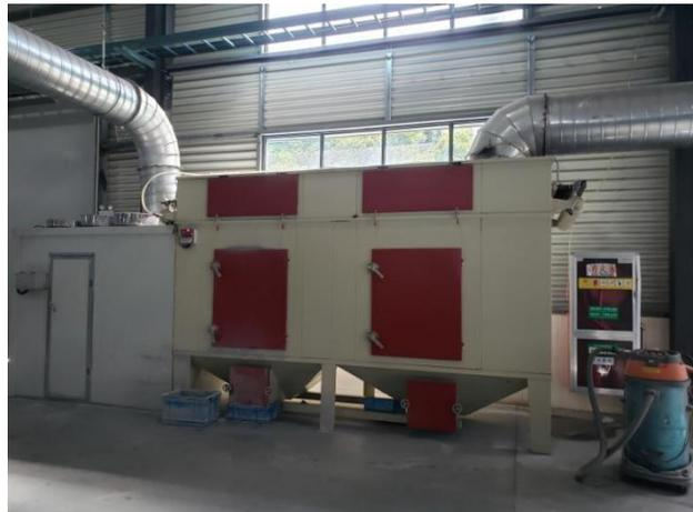
图 7：废气污染处理设备
