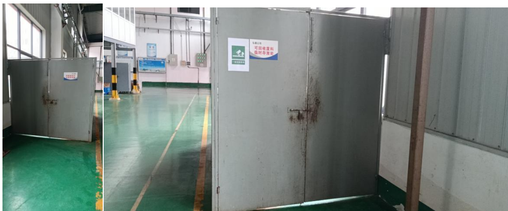
图 5-1 一般固废暂存场所
