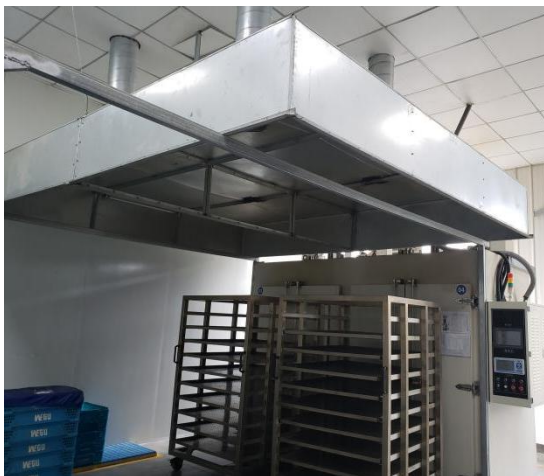
图 5：二段硫化废气收集及处理设施
