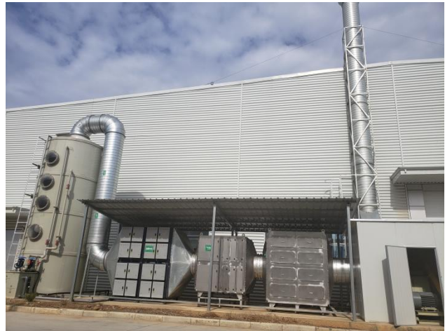
图 5：二段硫化废气收集及处理设施
