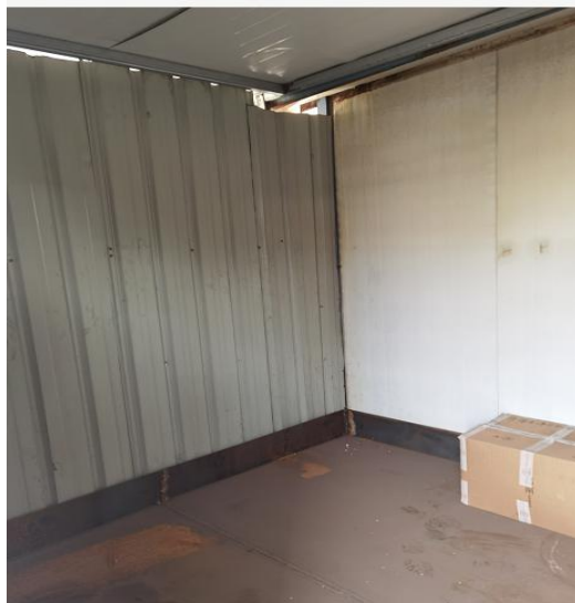
图 7-5 危险废物暂存场所
