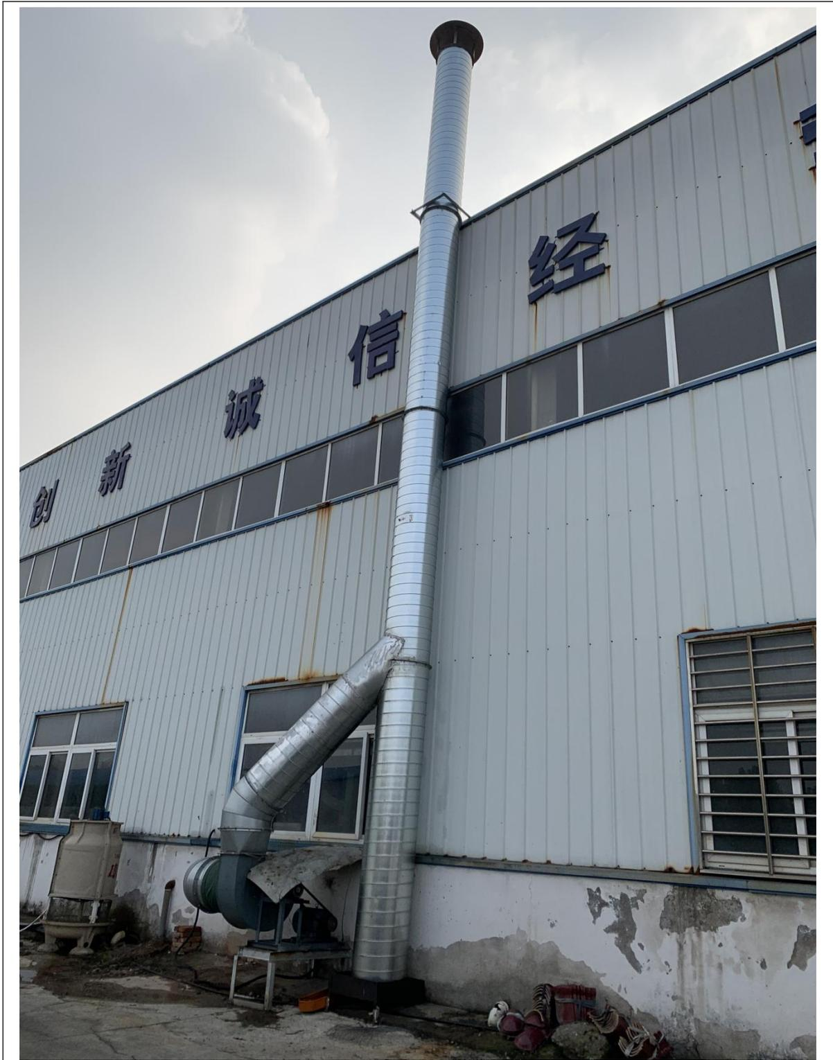
图 6-7 冷镦废气处理设施
