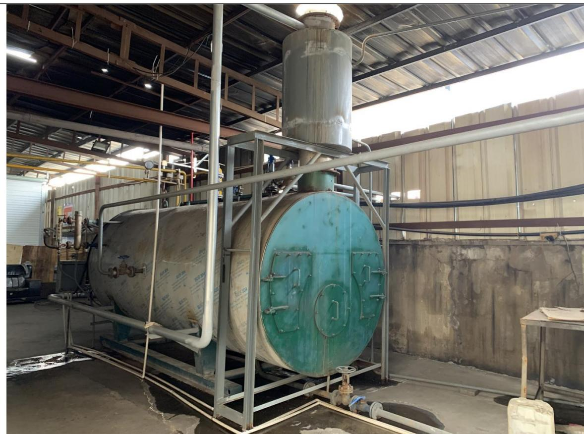
图 6-6 锅炉废气处理设施
