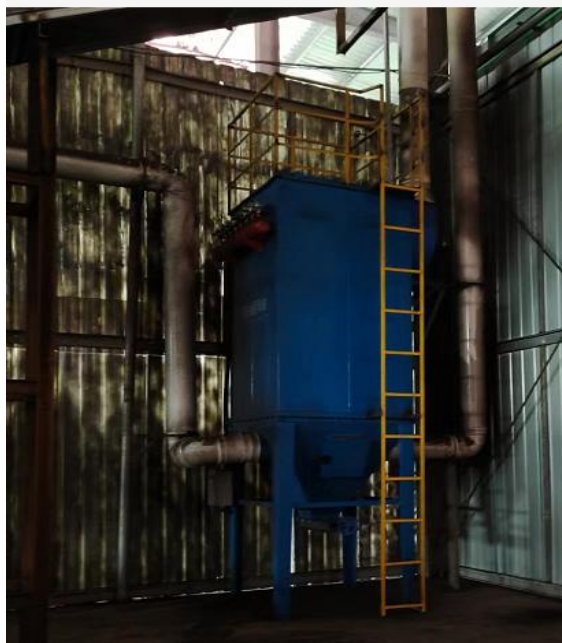
图 11：包装机废气处理设施
