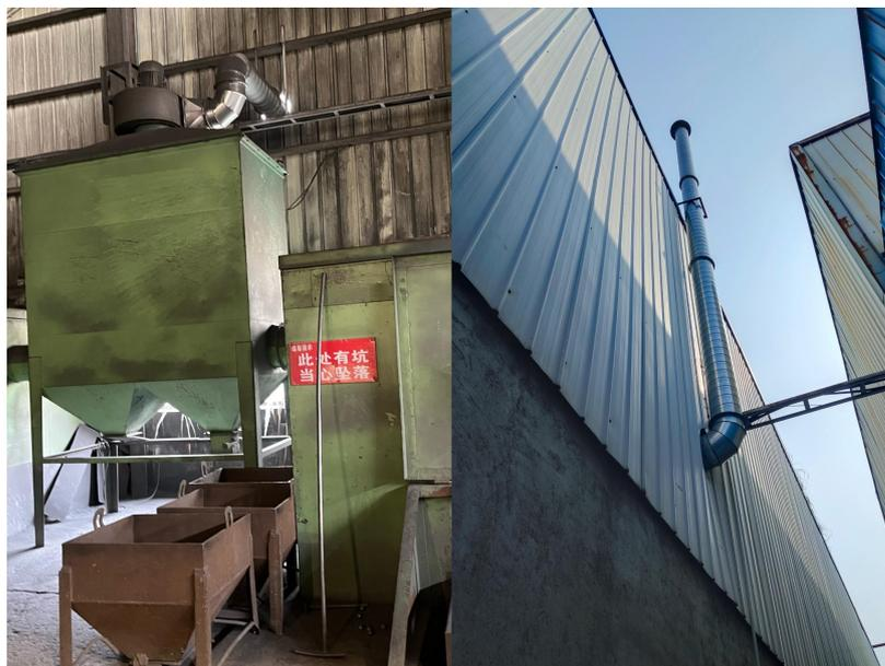
图 7-1 废气处理设施（布袋除尘+15 米高排气筒）
