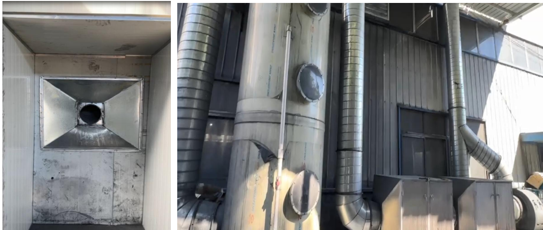
图 4-1 集尘罩+喷淋+二级活性炭处理工艺
