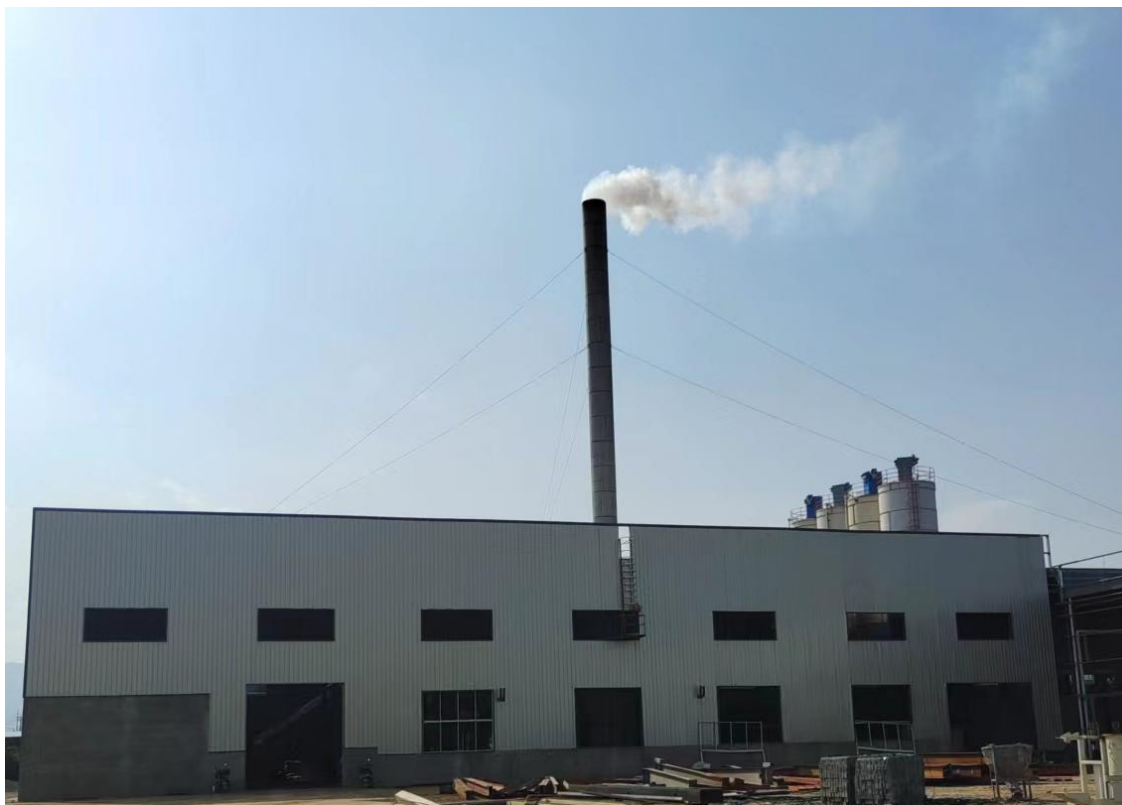
图 5-3 锅炉废气排气筒（DA003）
