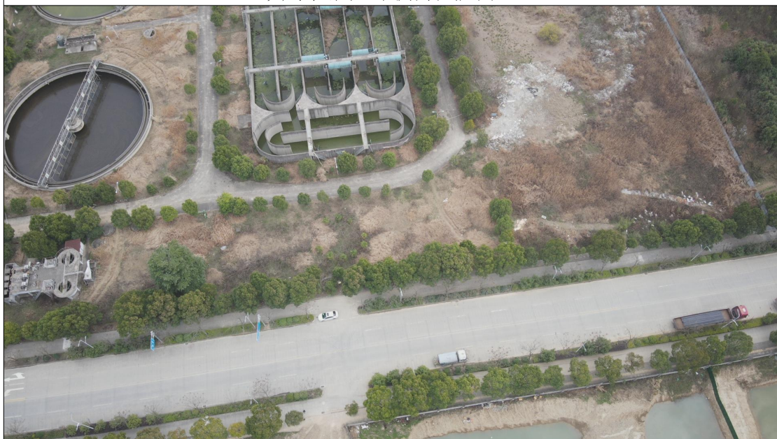
万家路东慈安路南、竹林路北万家路东地块边界南侧为竹林路，道路对面为原宁国市城建污水处理厂及荒地。
