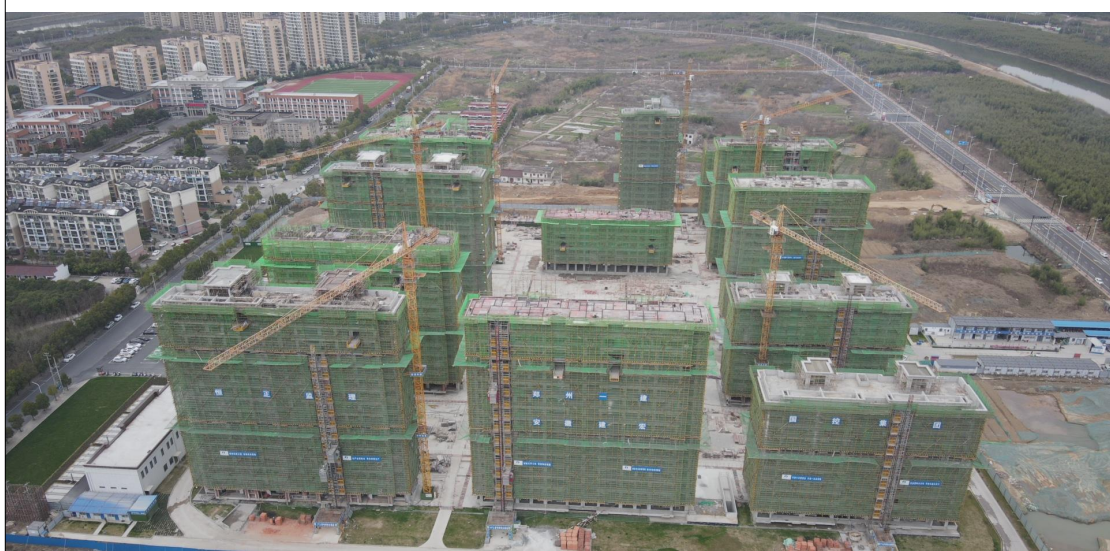
万家路东慈安路南、竹林路北万家路东地块边界北侧为慈安路，道路对面为农田及荒地。
