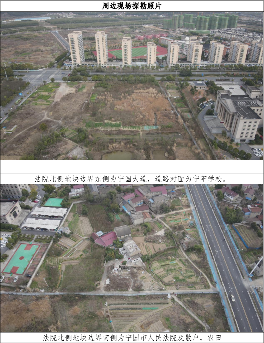
图3.5-1 法院北侧地块周边现场探勘情况
