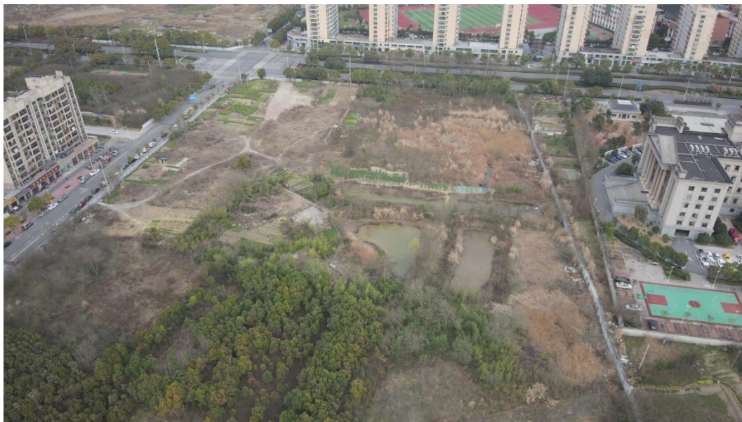
现场探勘照片
