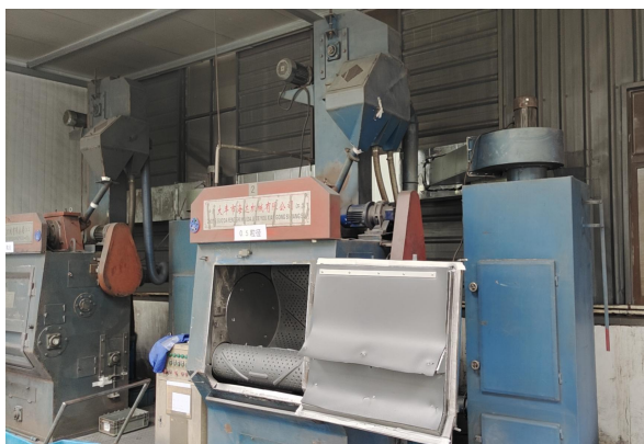
图 4-5 抛丸废气处理设施
