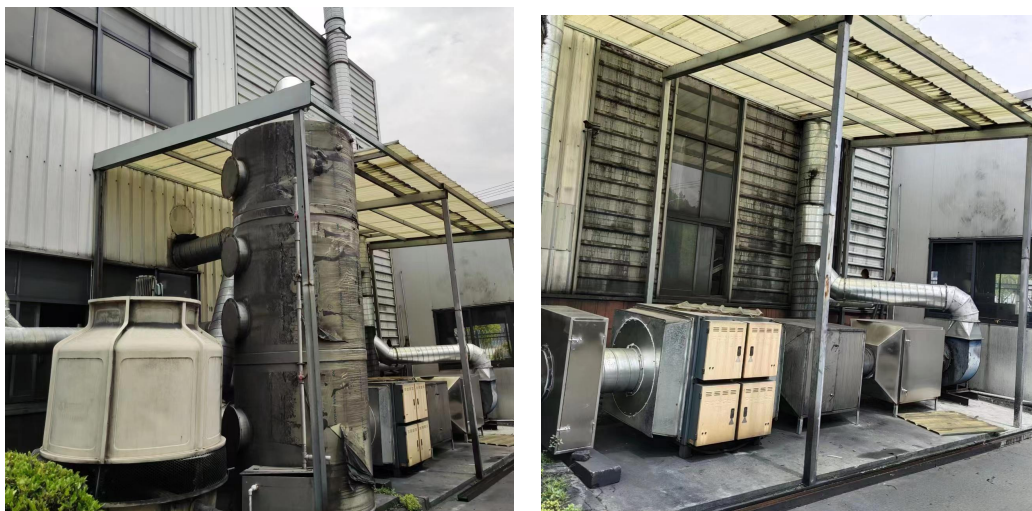
图 4-4 开炼密炼废气处理设施
