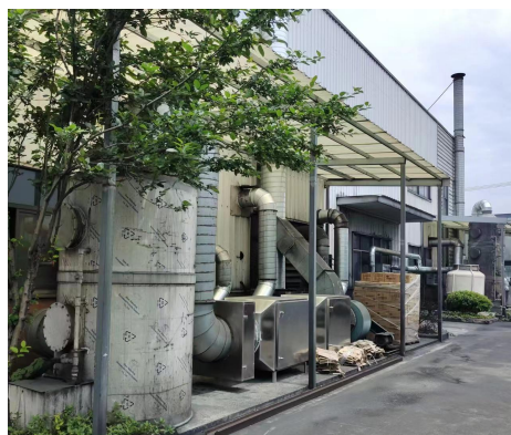
图 4-7 配胶、涂胶、烘干废气处理设施图
