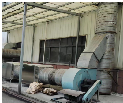
图 4-1 硫化废气处理设施
