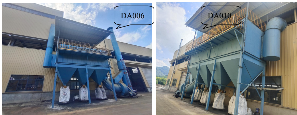
图 4-4 砂处理废气处理设施
