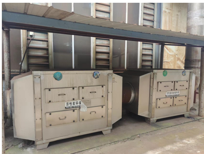
图 4-7 喷图、烘干废气处理设施图
