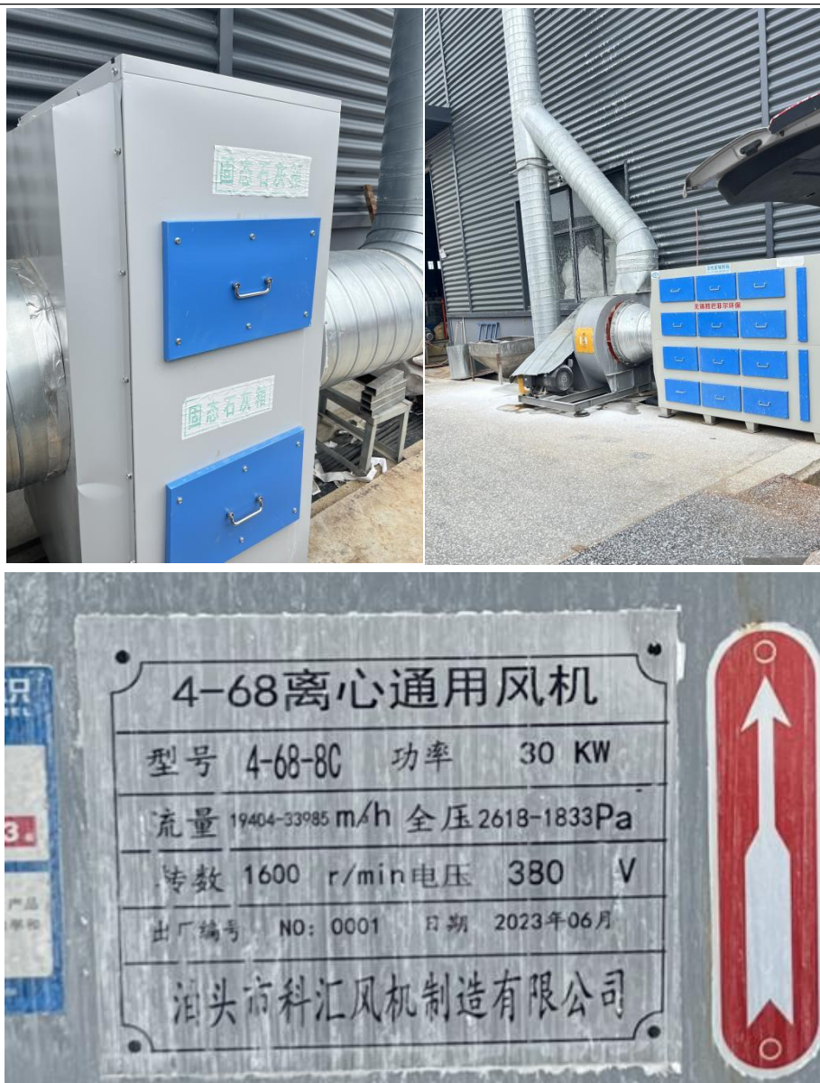
图 6-2 挤出、注塑、造粒废气处理设施
