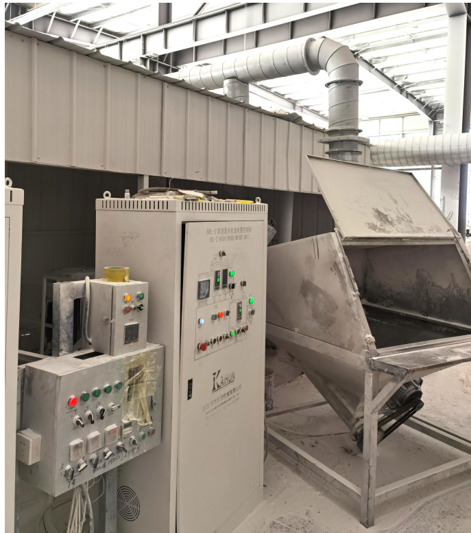
图 5-2 配料、混料、搅拌工序图
