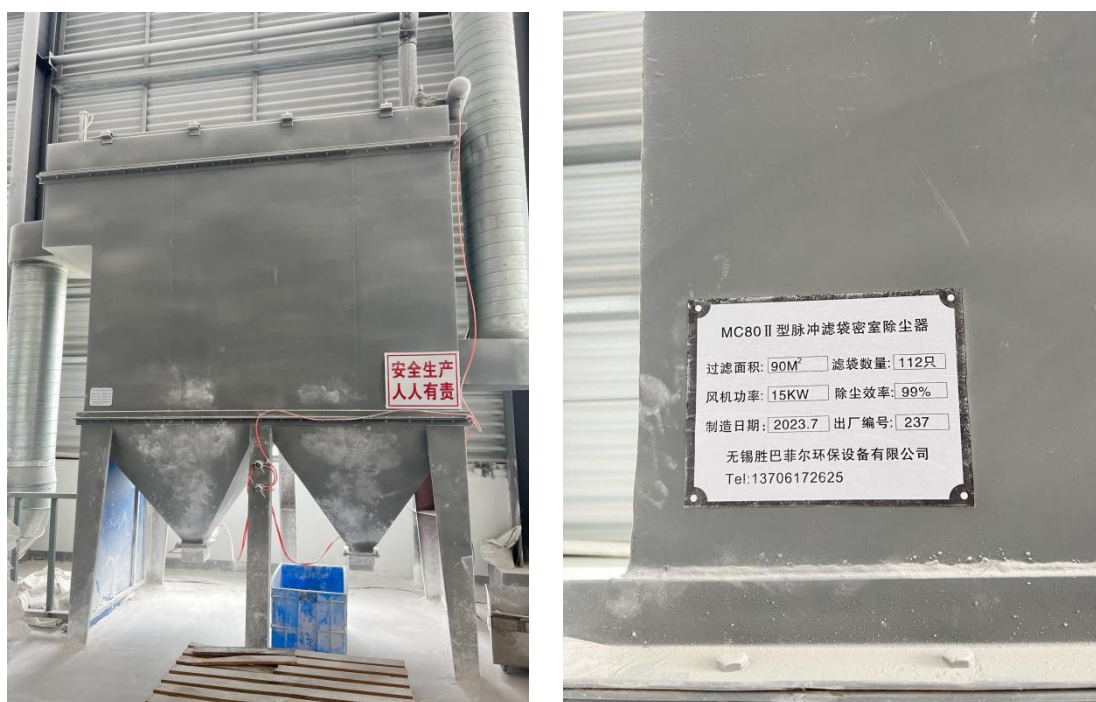
图 6-1 配料、混料、搅拌、破碎废气处理设施
