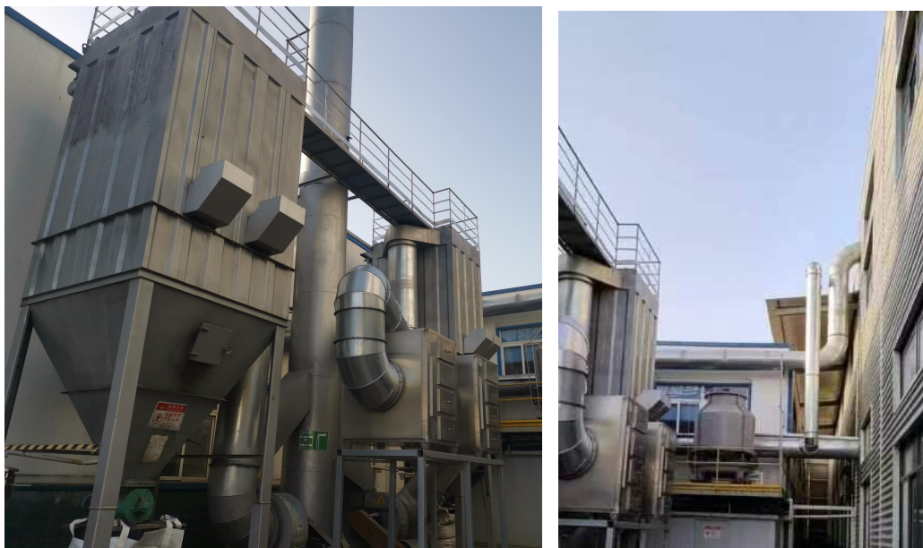
图 4-1 配料、投料粉尘、密炼、开炼、磨削废气处理设施（3#排气筒）
