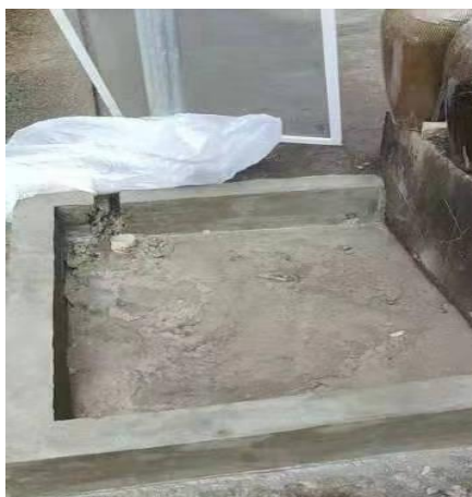
图5-6 洗坛场所设置废水收集措施
