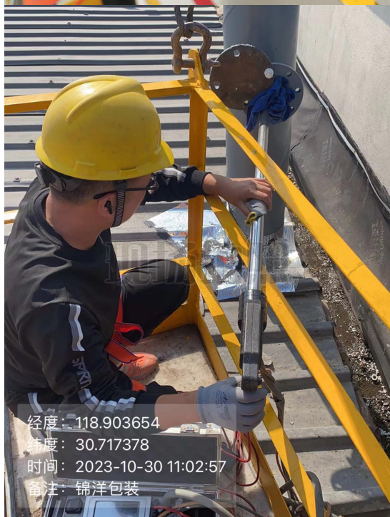
图 7-2 现场监测照片
