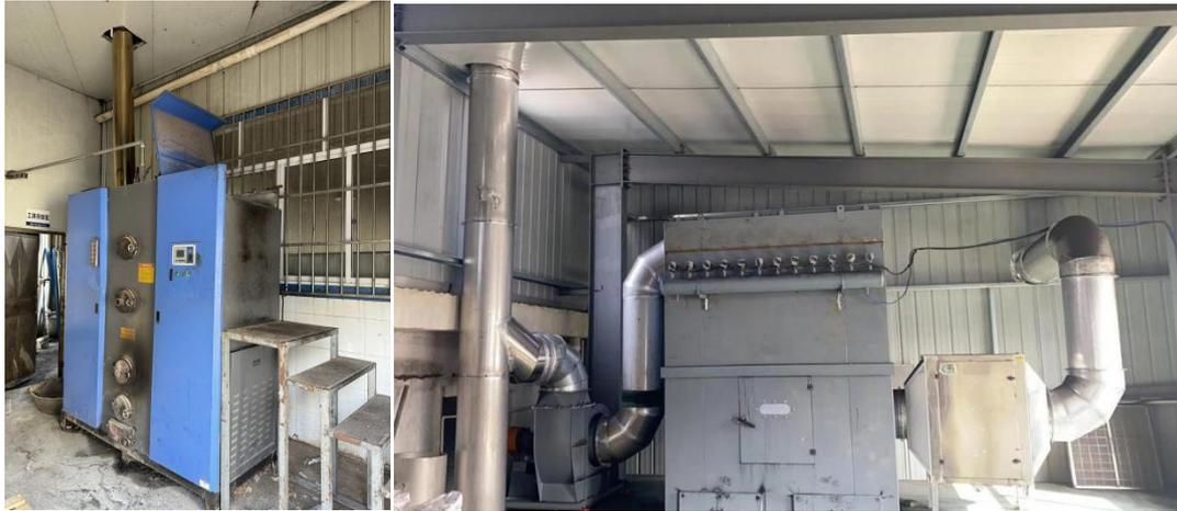
图 6-2 锅炉及废气处理设施
