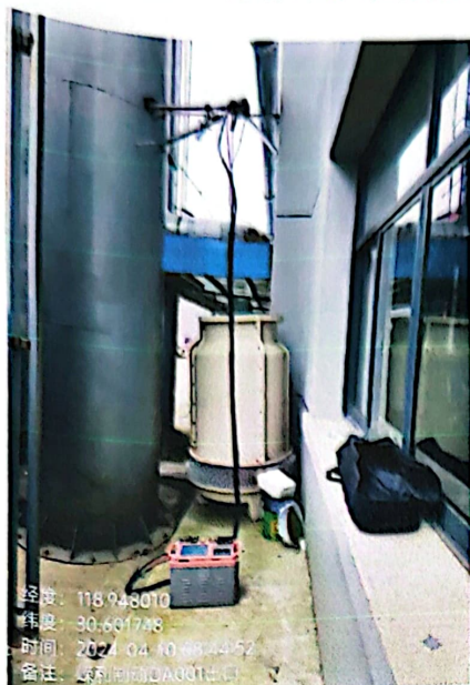
续 2.3 现场部分采样照片
