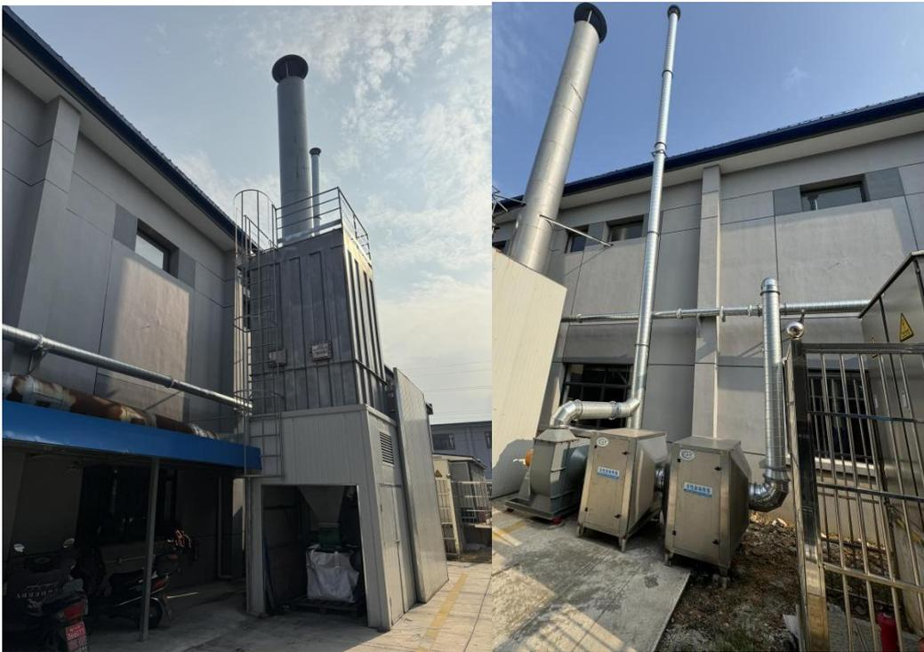
图 6-2 废气处理设施及排气筒
