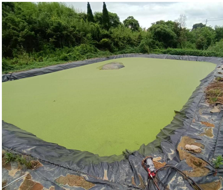
图 3-6-1 初期雨水收集池
