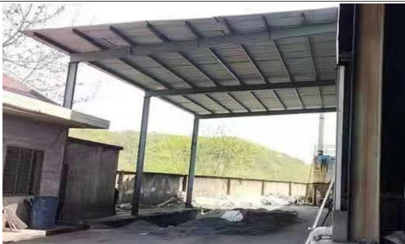
图 7-9 一般固废暂存间
