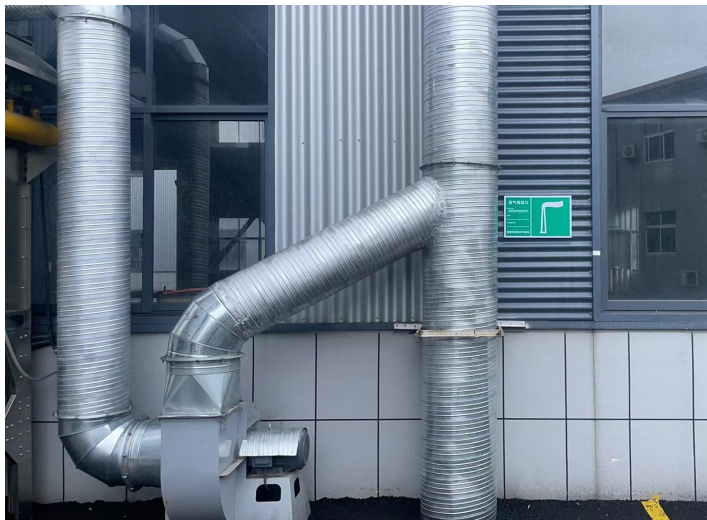
6-3 焊接废气处理设施图
