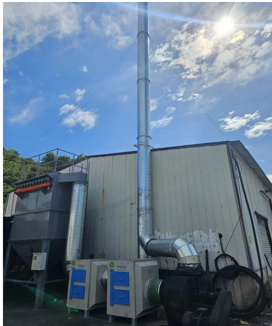
图 4-1 配料、密炼、开炼废气处理设施
