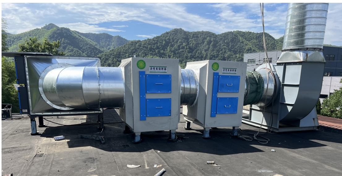
图 4-2 预成型、硫化废气处理设施
