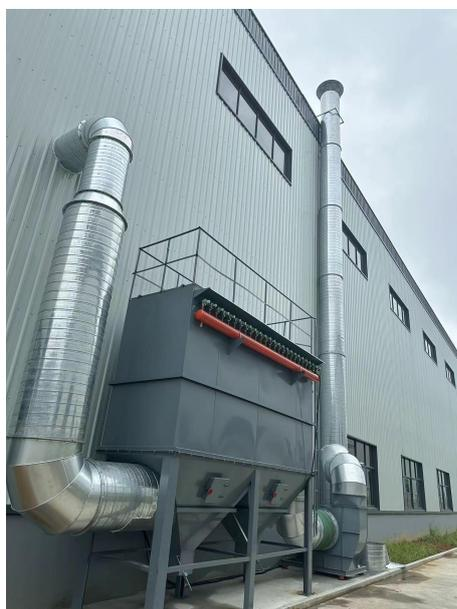
图 6-1 下料、焊接废气处理设施图
