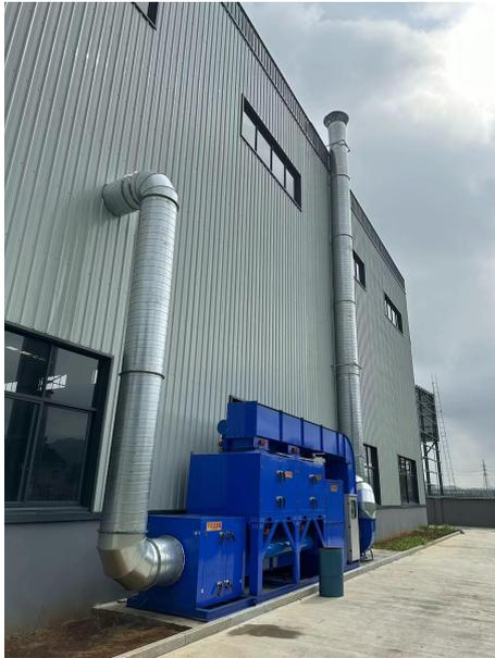
图 6-3 喷漆、晾干废气处理设施图
