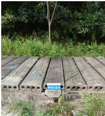
图 3-7-3 虹龙养殖场事故应急池
